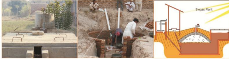
فیس ڈوم ڈیزائن کے بائیوگیس پلانٹ کا خاکہ بائیوگیس پلانٹ کی تعمیر کا ایک منظر تعمیر شدہ بائیوگیس پلانٹ کی تصویر
